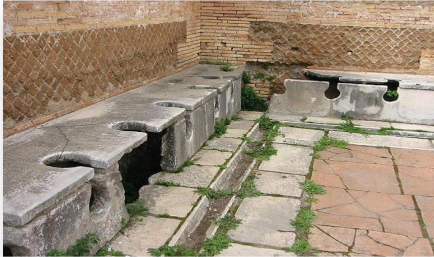
Figura 1: Latrinas (banheiro público) construída no século I d.C (ROCHA, 2004).
